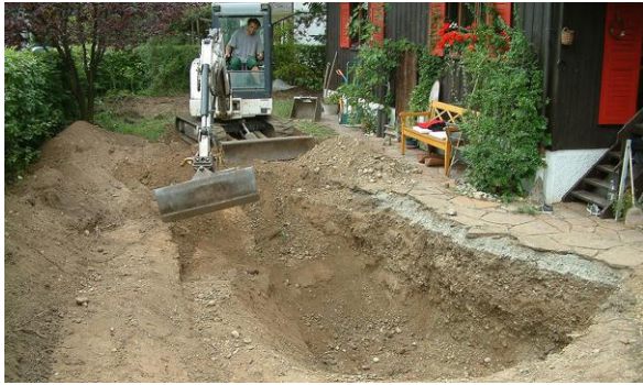
Sinnvoll bei größeren Teichen – Aushub mit dem Bagger
