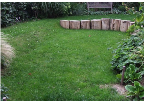
Rasenmulde als Sickerung im Hausgarten
