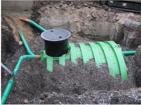
Einbau einer Zisterne
