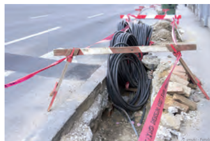
Die Telekom investiert mehr als sechs Millionen Euro in modernste Breitbandtechnik für schnelles Internet. Schon im Februar beginnen die Bauarbeiten.
