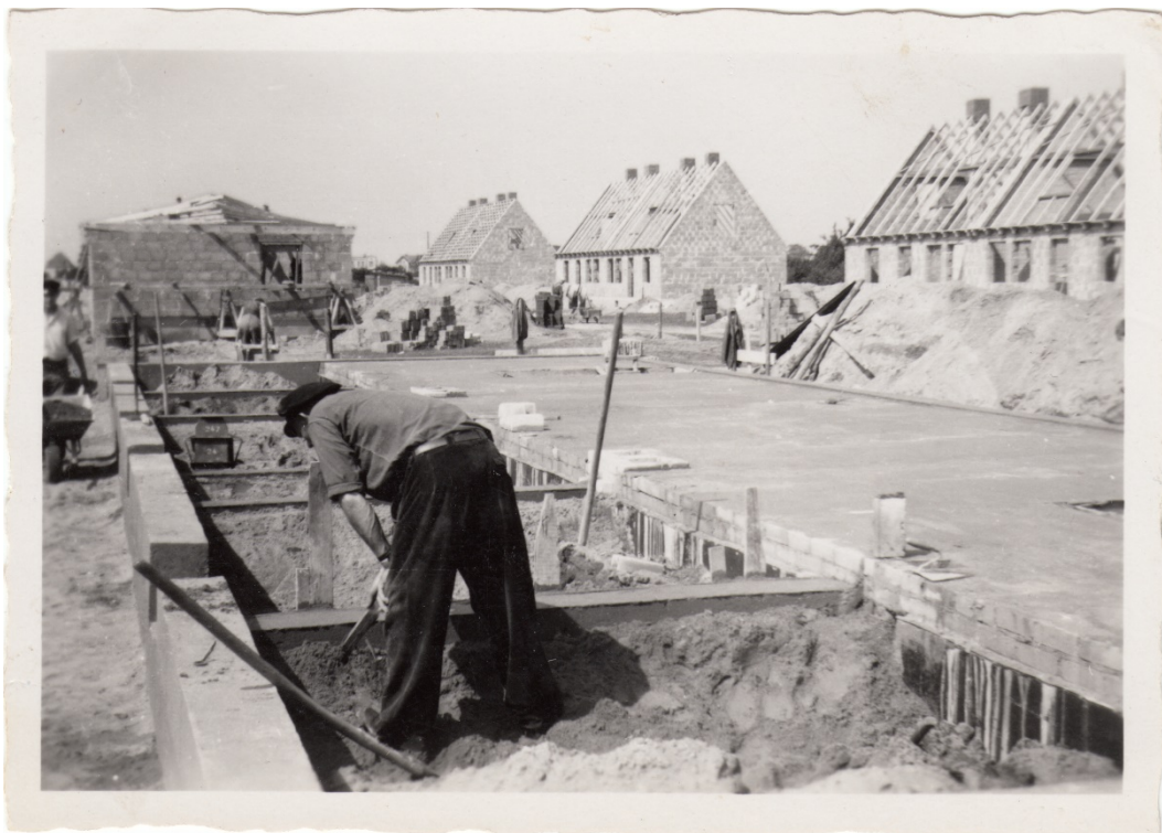
Harte Arbeit im heißen Sommer 1952 – Zukünftige Siedler beim Bau in Eigenhilfe. Siedlungshäuser der Baugenossenschaft „Eigener Herd“ im Dahlienweg.
