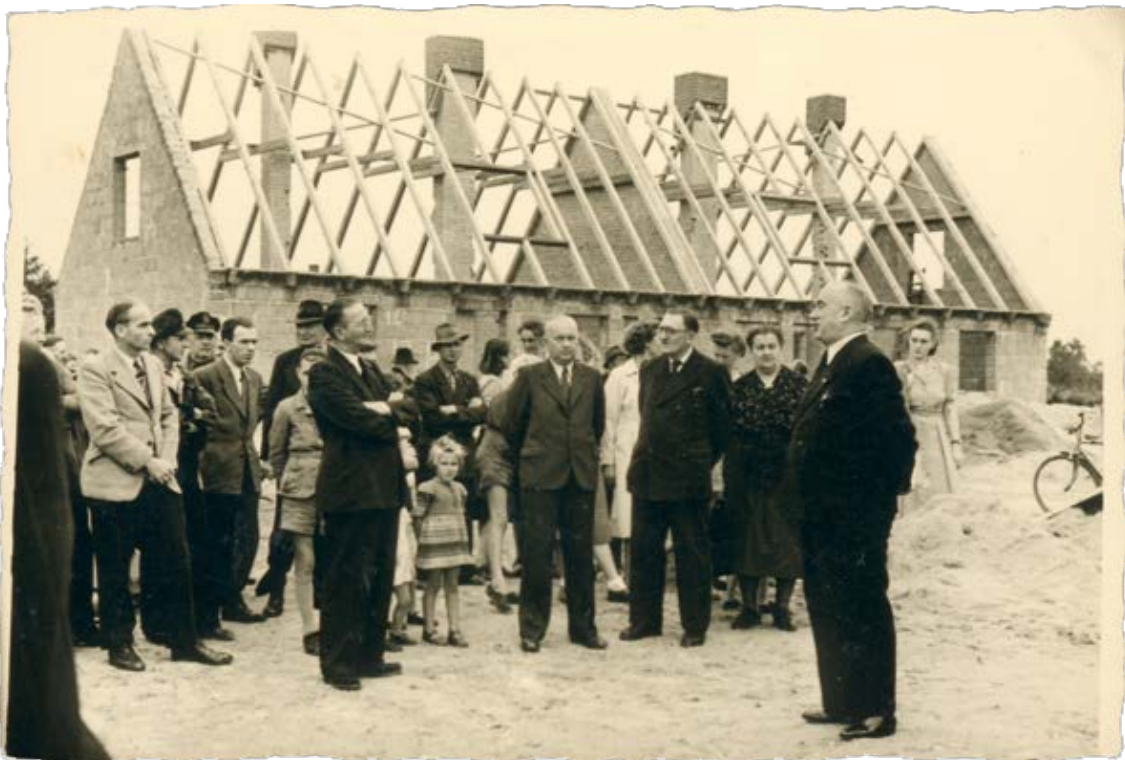
August 1952 – Richtfest im Dahlienweg in Tungendorf Ansprache des Aufsichtsratsvorsitzenden der Baugenossenschaft „Eigener Herd“, Wilhelm Poppeck (vorne rechts)
