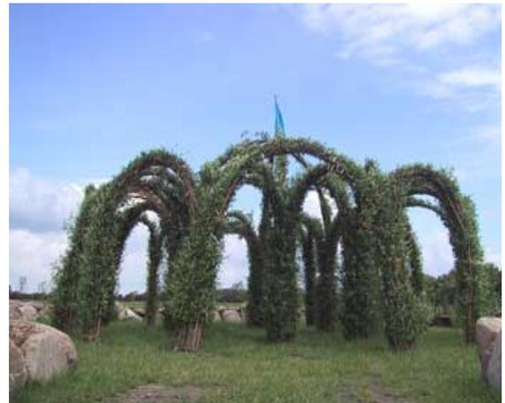
**Bauanleitung Tunnel:** Die Enden von 2,5 bis 3 Meter langen Ruten werden wie beim Iglu zuerst auf einer Seite eingegraben, über eine Tunnelbreite von etwa 80 cm gebogen und dann auf der gegenüberliegenden Seite befestigt. Auch hier können wieder Zwischenräume mit jungen Ruten ausgefüllt werden. Bei der Anlage von längeren Tunnels sind seitliche Öffnungen als Fluchtwege zu empfehlen.
