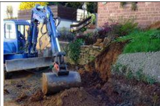
Wer baggert so spät im Baggerloch? (20.03.)
