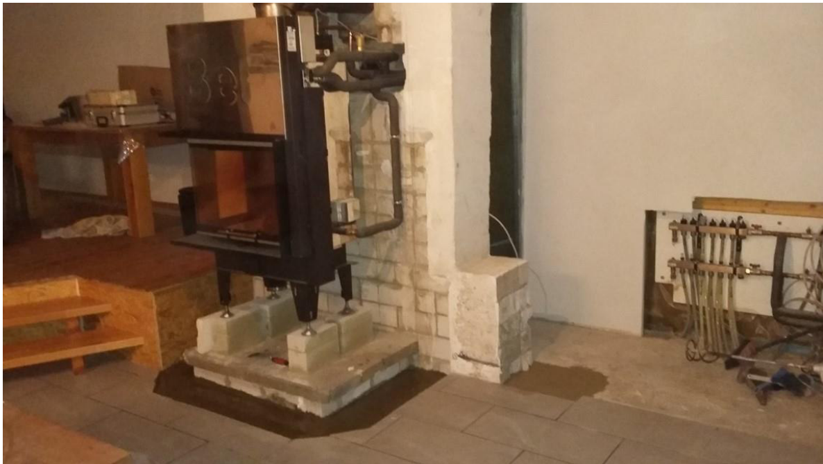
Einbau eines wassergeführten Kaminofens (14 kW)
