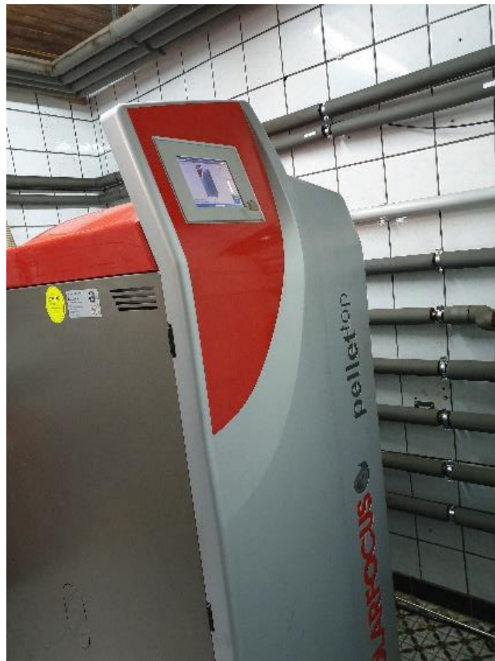
Eine 25 kW-Pelletanlage
