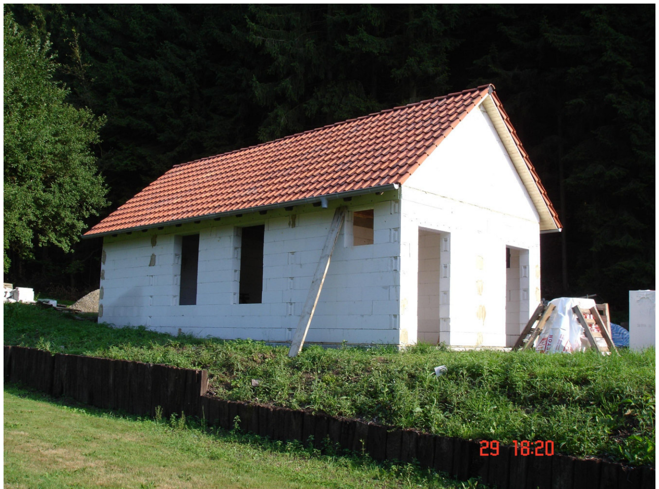
Der Rohbau ist fertiggestellt.
