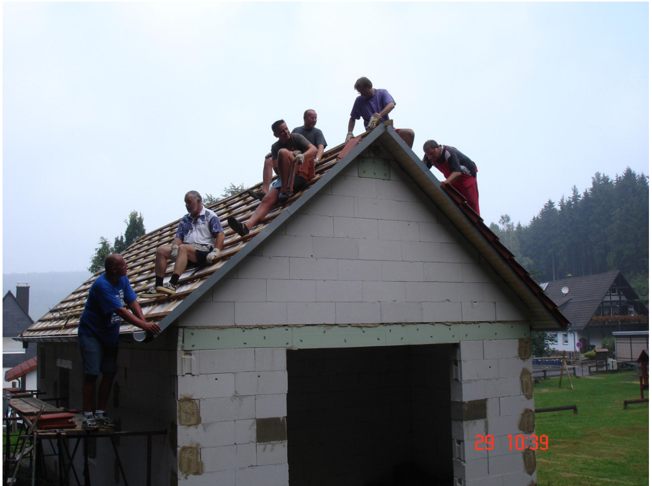
Das Dach wird eingedeckt.
