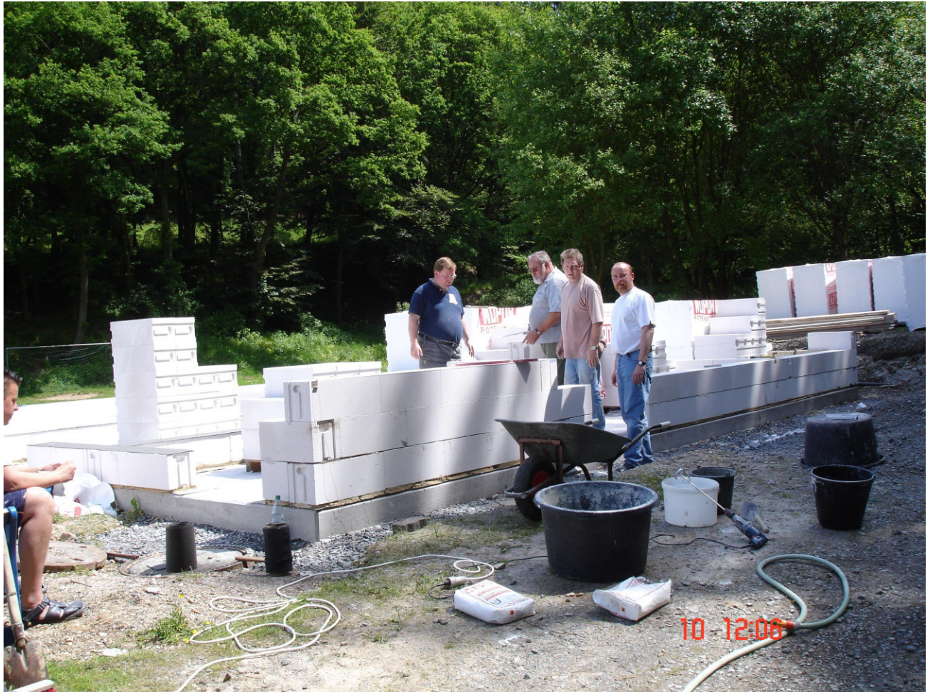
Die Bodenplatte ist fertig und es wurde mit den Mauerarbeiten begonnen.
