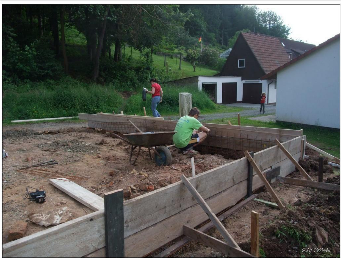
Einschalen der Fundamente.
