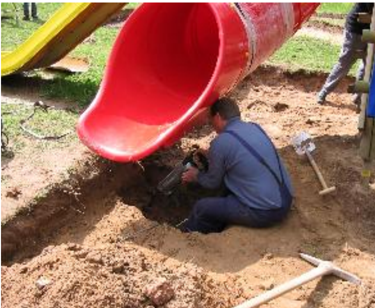
ALFRED BERGER LEISTET VOR DEM BEFESTIGEN DER RUTSCHE LETZTE „FEINARBEITEN“.
