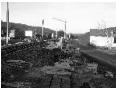
Baustelle im Bereich des ehem. Bahnhof Eschenstruth
