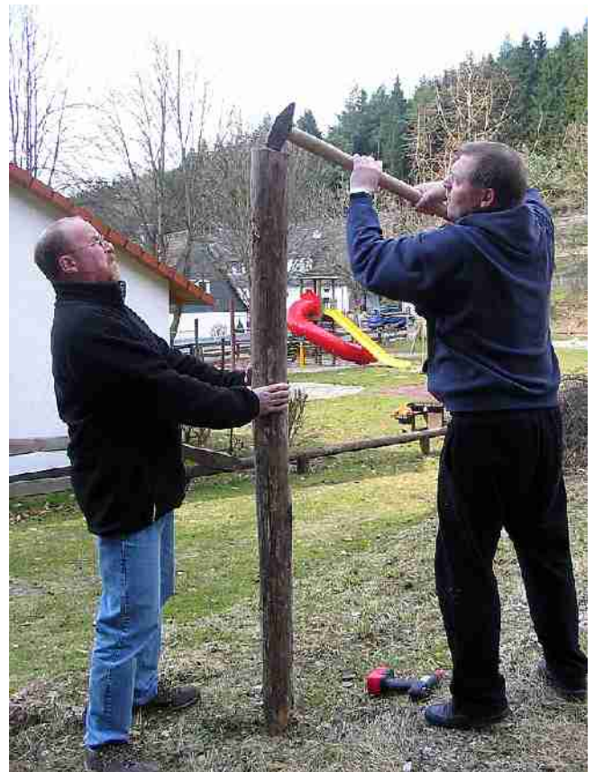
Abbildung 3: Alfred Berger und Olaf Wieder beim Aufstellen des Bauschildes am 07.04.2006
