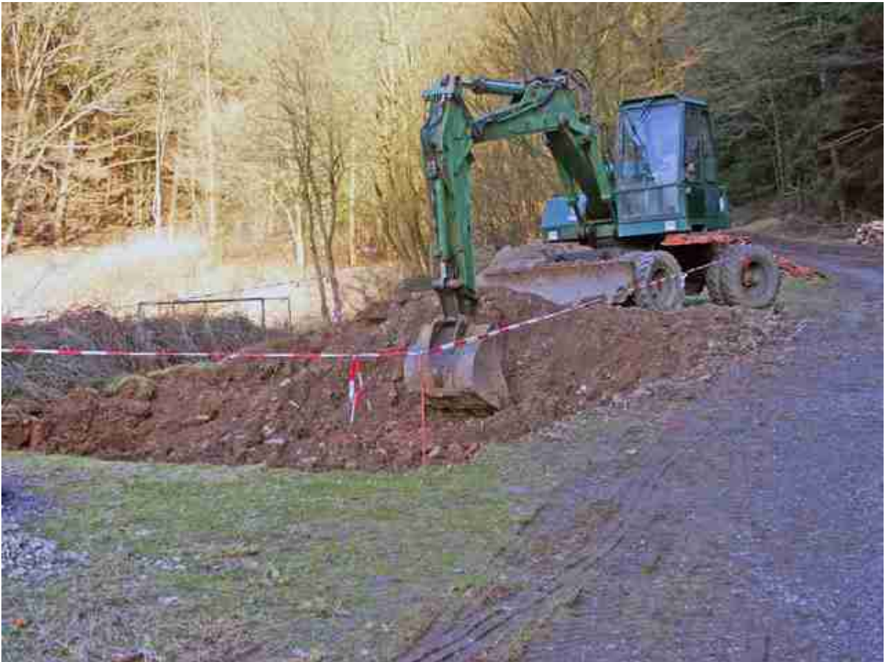
Abbildung 2: Der Bagger beim Ausheben der Baugrube
