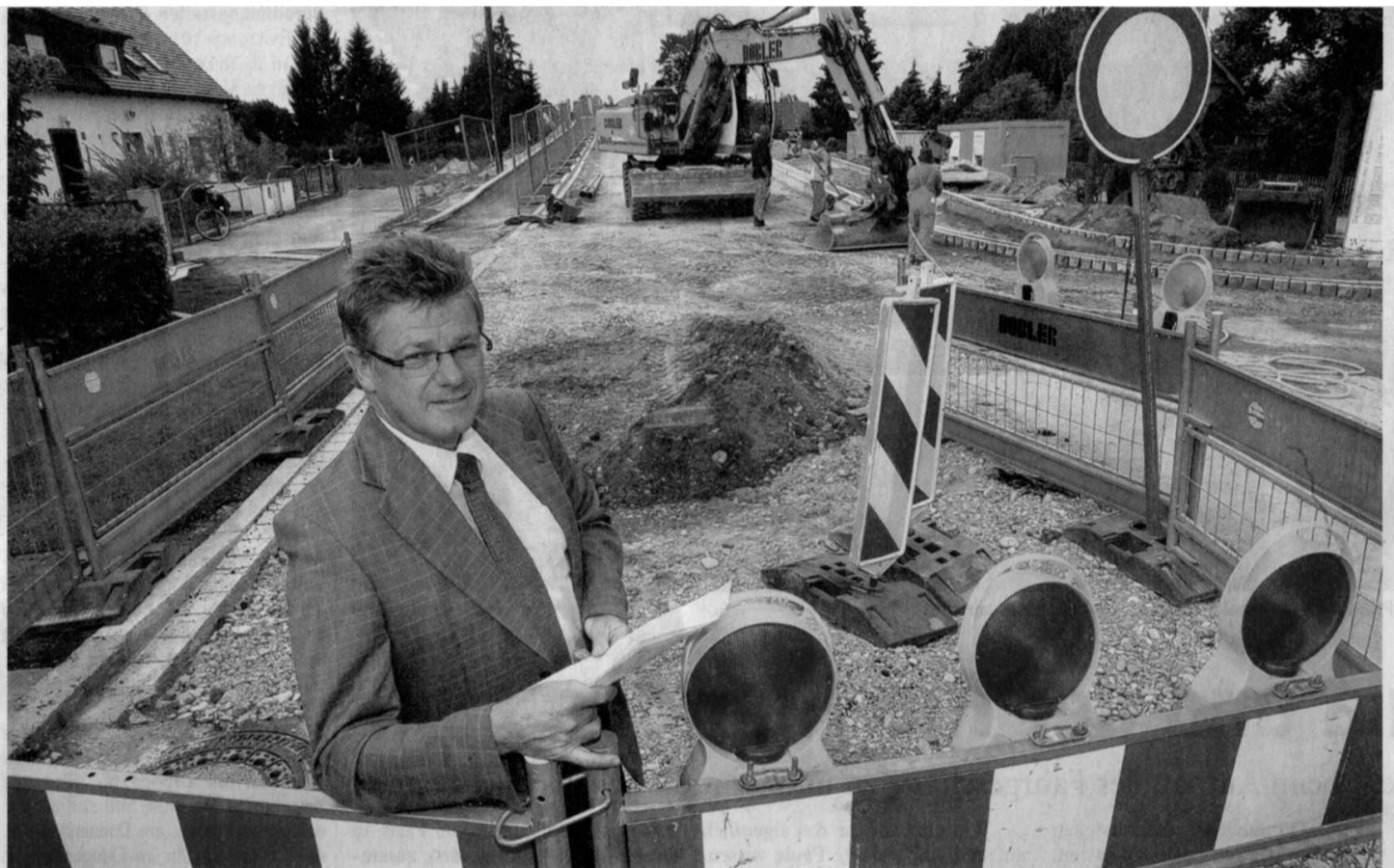
Für motorisierte Fahrzeuge ist hier in der Straße Am Wachtelschlag momentan noch Schluss. Tiefbauamtsleiter Josef Weber freut sich, dass die neue Roggenfeldbrücke am kommenden Montag freigegeben wird. Fotos: Annette Zoepf
