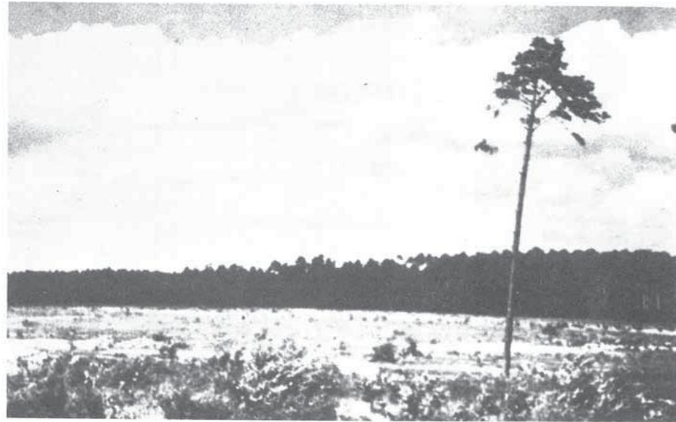
So sah es vor Baubeginn aus: Wald, Buschwerk, Sandwüste mit den Wurzeln der abgeholzten Bäume.
