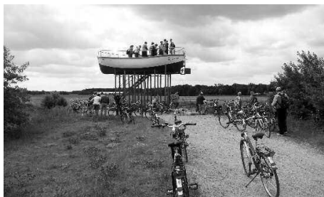
„Überlandboot“ – Schaubaustelle Überleiter 12
