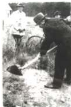
Der erste Spatenstich von Werkdirektor Schlosser im September 1936.
