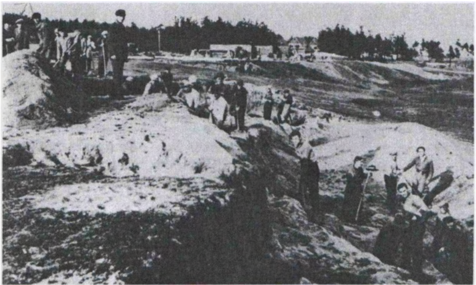
Siedler beim Erdaushub.
