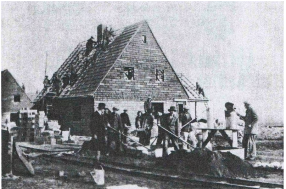
Baubeginn in der Oberen Damaschkestraße.
