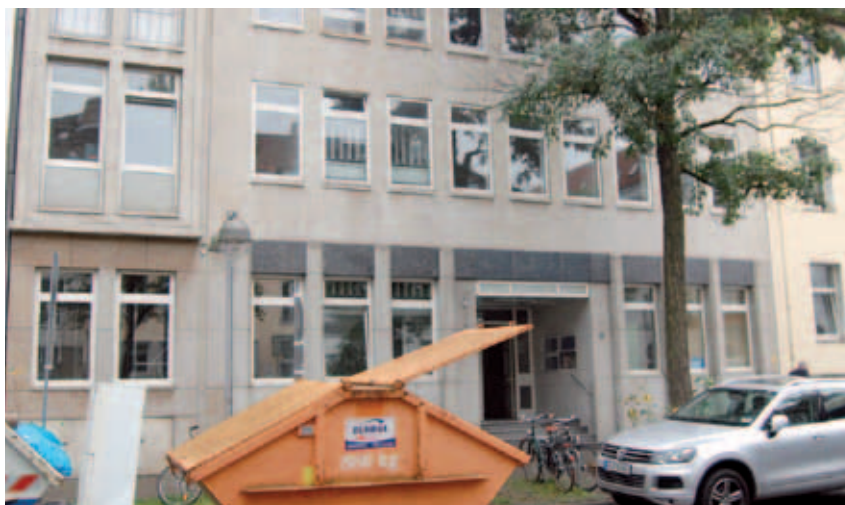
Noch lassen Müll- und Bauschuttcontainer vor der Königstraße 22 in Hannover auf umfangreiche Baumaßnahmen schließen. 450 Quadratmeter im Erdgeschoss und in der ersten Etage stehen der zukünftigen Landesgeschäftsstelle zur Verfügung.
