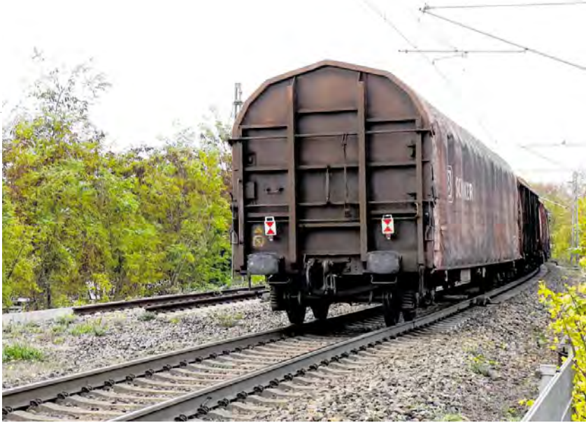
Noch ist die Trasse eingeleist. Das abgebaute Gleis (links, aufgenommen an der Neckarbrücke bei der Feudenheimer Schleuse) soll reaktiviert werden. BILD: TRÖSTER
