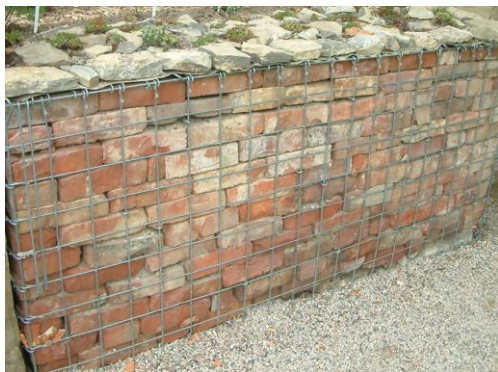
Gabionenmauer aus alten Ziegelsteinen
