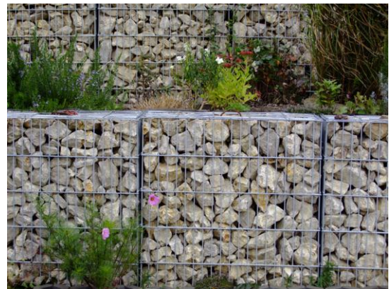
Gabionenmauer zur Hangabstützung, mit gebrochenen Steinen gefüllt.
