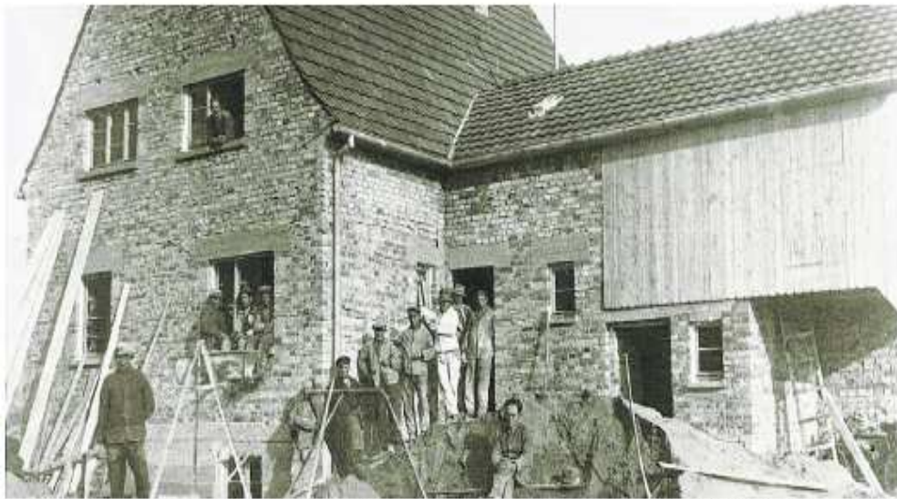
Es ist geschafft: Der Rohbau steht! Richtfest für eines der ersten Häuser in der damaligen IG-Siedlung 1933, heute Stadtteil Rheinau-Süd. Die Häuser wurden übrigens unter den Bauleuten erst nach ihrer Fertigstellung verlost, damit sich auch ja jeder der Bauleute bei jedem Haus gleich viel Mühe gab. BU 7H
