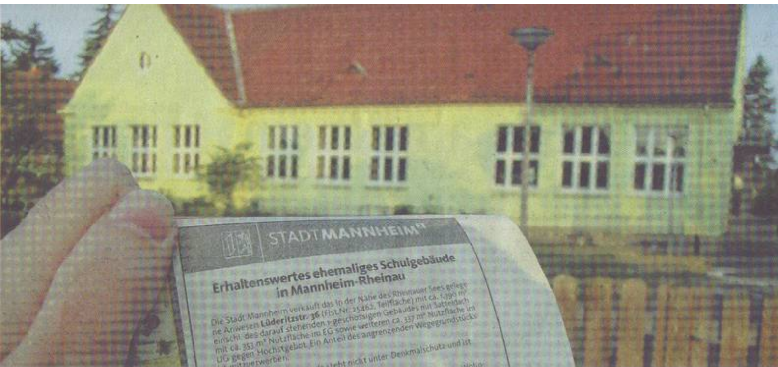
„Erhaltenswertes ehemaliges Schulgebäude“: Mit diesem Slogan wirbt die Stadt für das Bauwerk, das – wenn sich kein Käufer findet – abgerissen wird.
