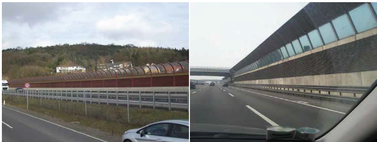
Abbildung 5: Beispiel einer gekrümmten und einer abgewinkelten Lärmschutzwand
