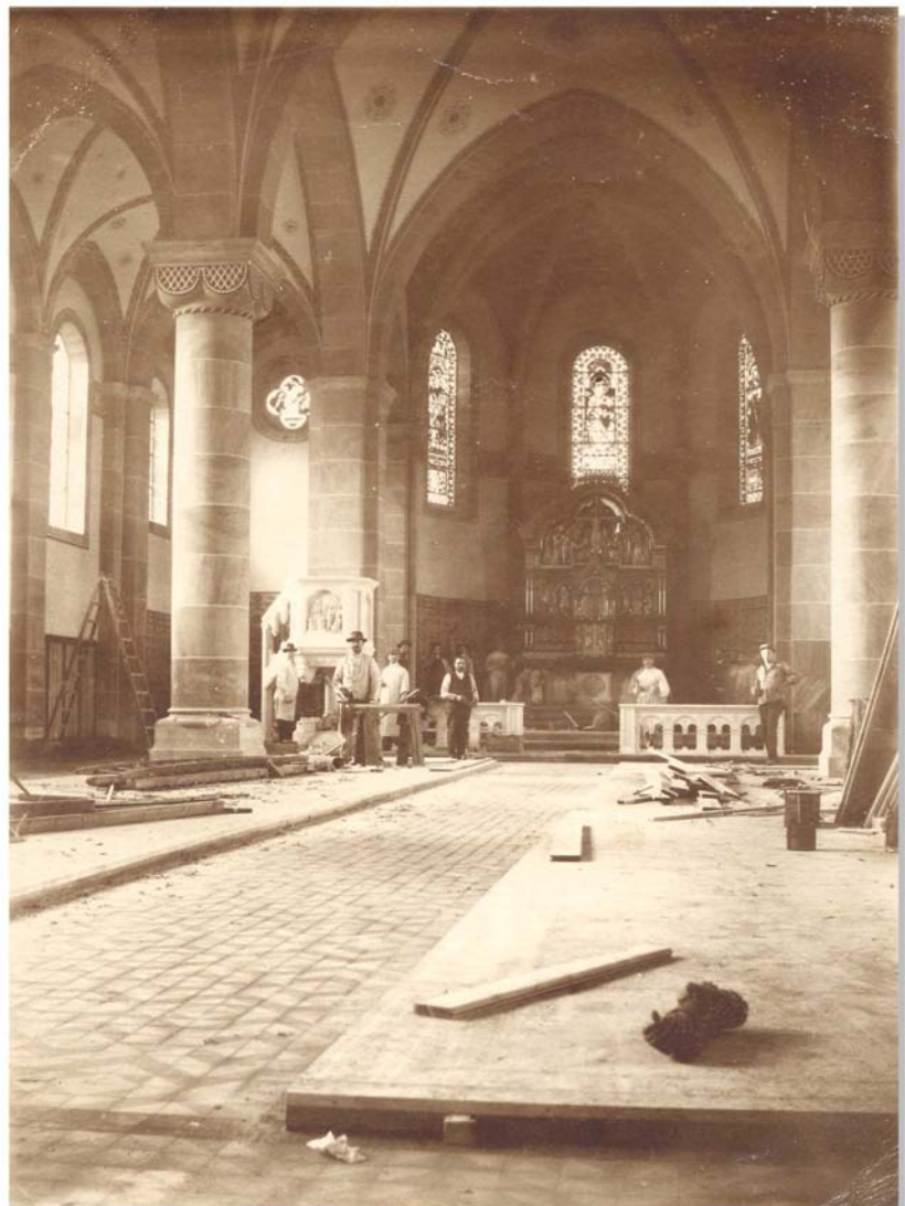
Innenausbau der Kirche - kurz vor der Fertigstellung
