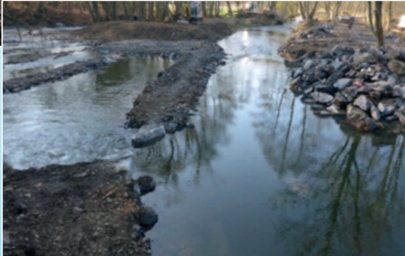
Abbildung 2: Nachher – Schlitz mit <0,14m Wasserspiegeldifferenz.
