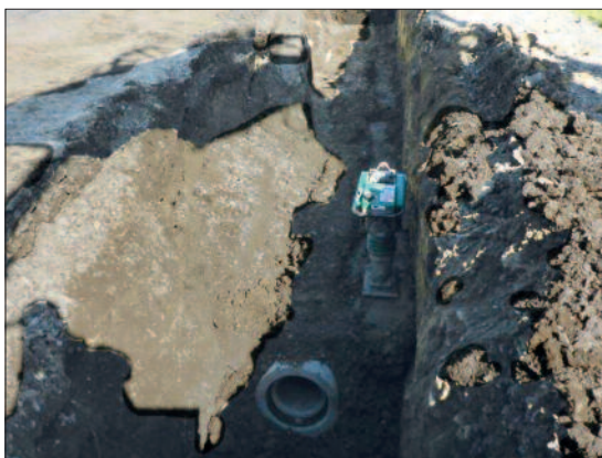
Die vorhandene Regenwasserleitung wurde im Sichtgrovor Teil des Grenzweges verlängert.
