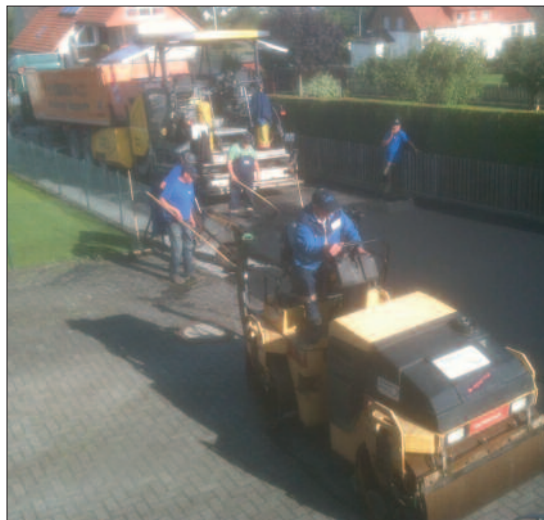
Am 11. September wurden die Asphaltierungsarbeiten abgeschlossen. Bilder: Simon
