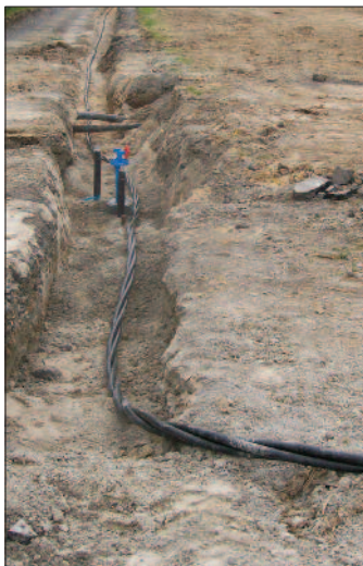
Auch das Stromkabel mußte erneuert werden.
