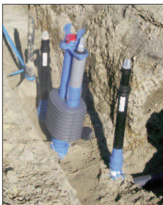
Die Trinkwasserleitung mußte erneuert werden.
