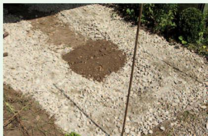
Als Untergrund wird der Oberboden durch Kies ersetzt
