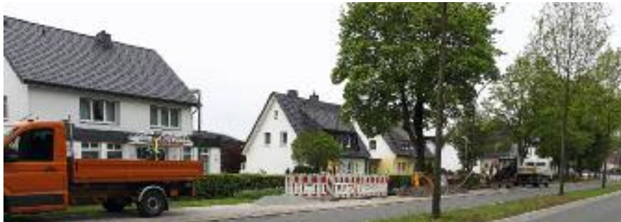
Dieses Bild zeigt, eindeutig, dass in Sichtigvor an der Möhnestraße noch an der Ringleitung gearbeitet wird (Stand: Mitte Mai 2019). Foto: Eilhard
