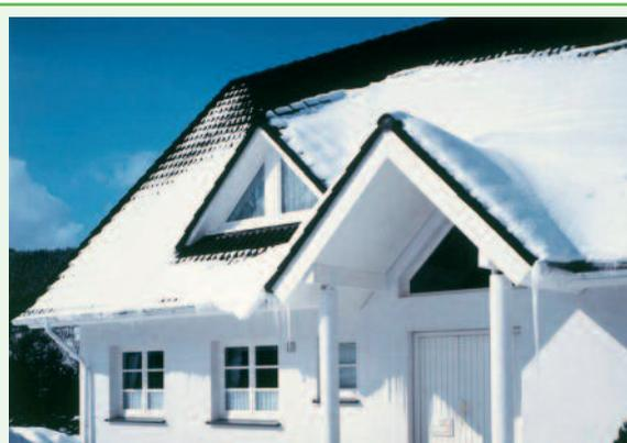
Eine geschlossene Schneedecke auf der Dachhaut ist der ideale Indikator, ob die Dämmung intakt ist – finden sich dunkle Stellen, deutet dies auf ein Dämmleck hin
