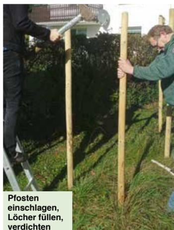
Pfosten einschlagen, Löcher füllen, verdichten
