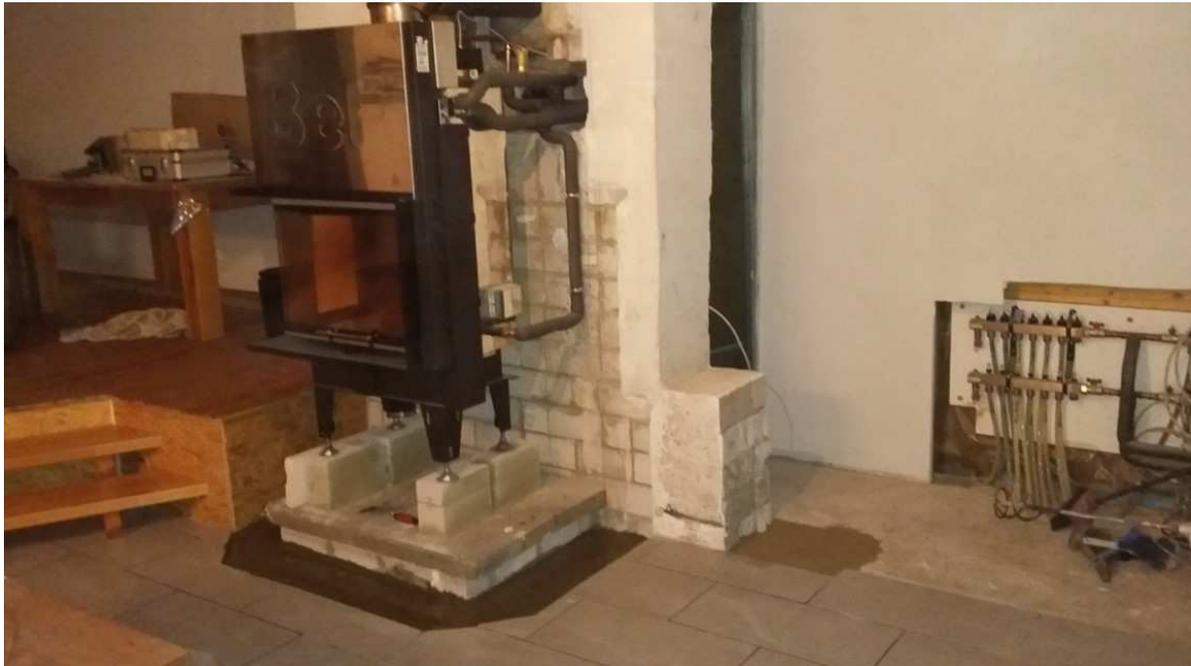
Einbau eines wassergeführten Kaminofens (14 kW)
