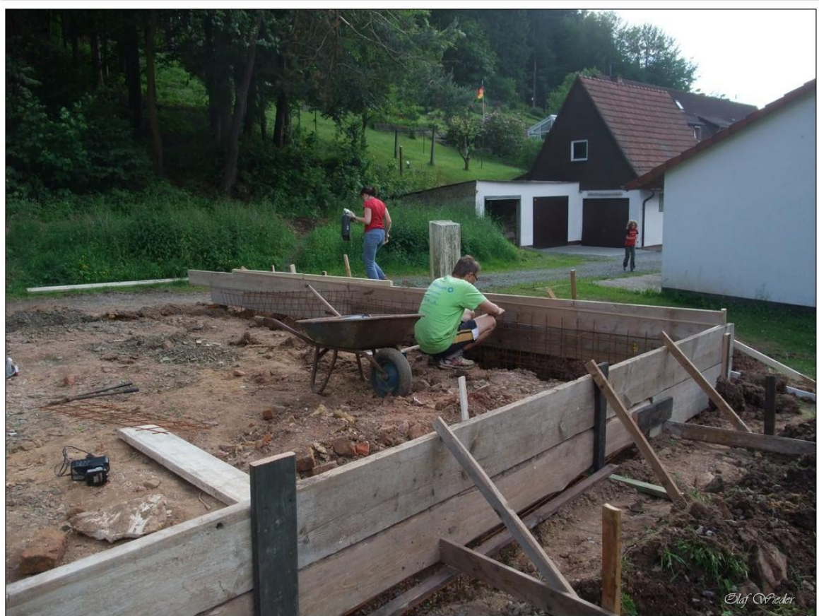
Einschalen der Fundamente.
