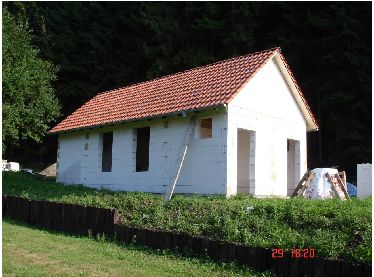
Der Rohbau ist fertiggestellt.
