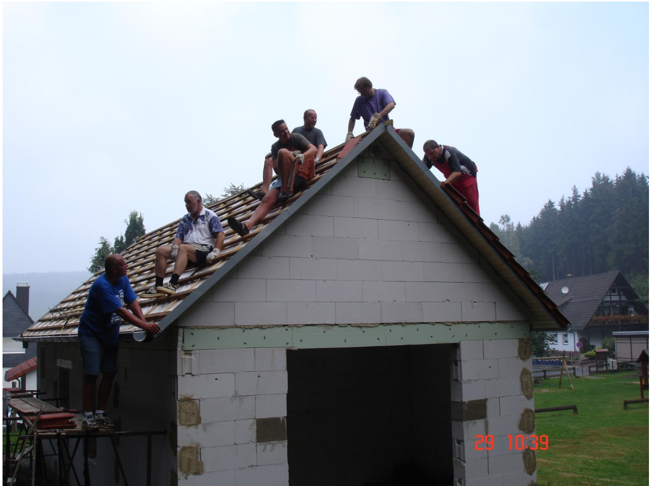
Das Dach wird eingedeckt.
