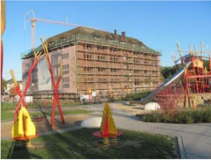
Das Magazingebäude mit vorgelagertem Kinderspielplatz aus Sicht von der Seeseite.
