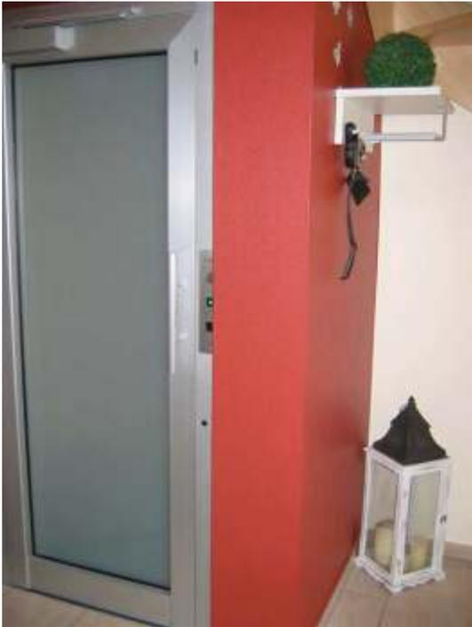
Die Janzhoff-Spezialisten haben den HomeLift innerhalb des Treppenhauses installiert. Ein Mauerschacht mit den Abmessungen 1.360 x 900 mm, eine Schachtgrube von 100 mm, ein Schachtkopf von 2.450 mm (normale Geschosshöhe) sowie eine normale 230 V-Steckdose reichten aus, um dieses Haus auch fürs „Alter“ aufzurüsten.
