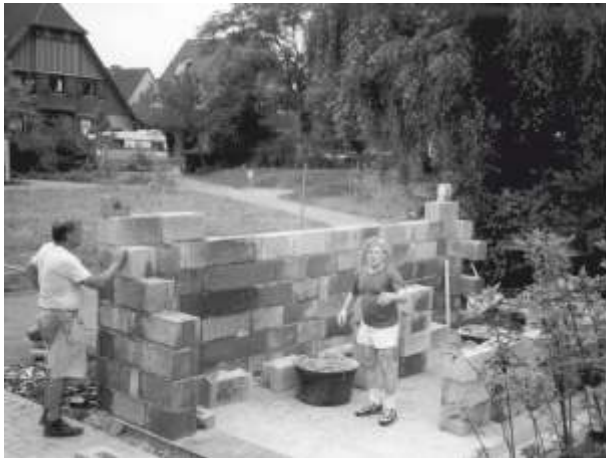
Fundament war gegossen und die erste Wand wurde gemauert.
