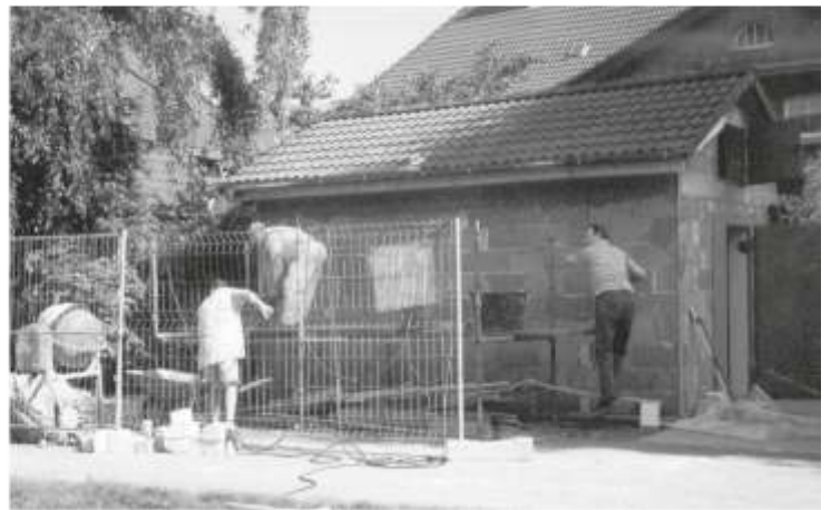
Der Rohbau war geschafft, nun wurde verputzt.
