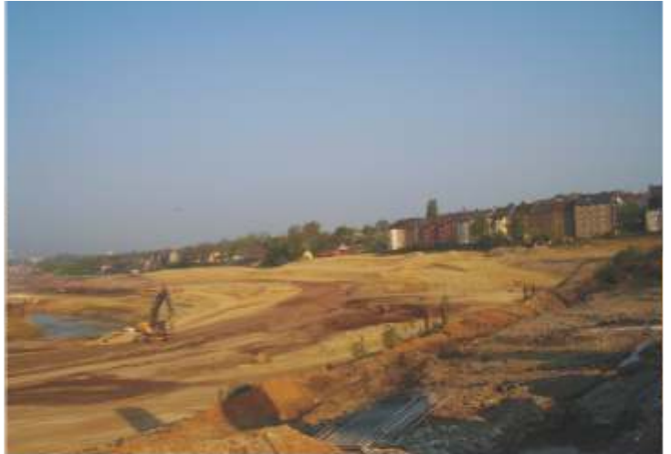
Die Baugrundstücke zum Remberg sind terrassenförmig stark erweitert worden. Im Vordergrund ist schon das Seeufer zum Norden zu erkennen. Es hat sich schon einiges Grundwasser angesammelt.
