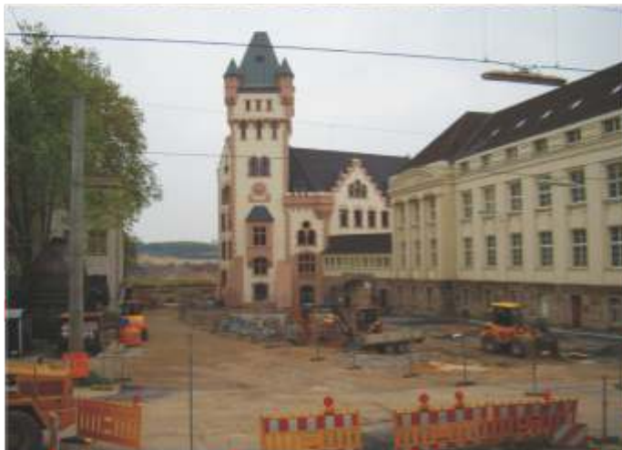
Teilansicht der neu renovierten Außenfassade der Hörder Burg und das angrenzende ehemalige Bürogebäude. Hier der Eingangsbereich der farblich gelungenen Neugestaltung, mit Blick auf die neue Turmspitze. Der Vorplatz wird nach langen Ausgrabungsarbeiten neu angelegt.
