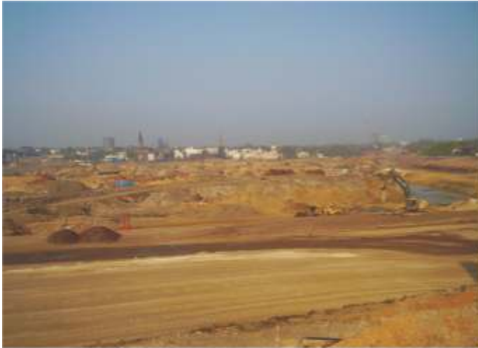
Ein Überblick auf die Großbaustelle Phönixsee. Im Hintergrund die Rückseite der Hörder Burg, die Hörder Kirchen und Teile des ehemaligen Hochofenwerks.
