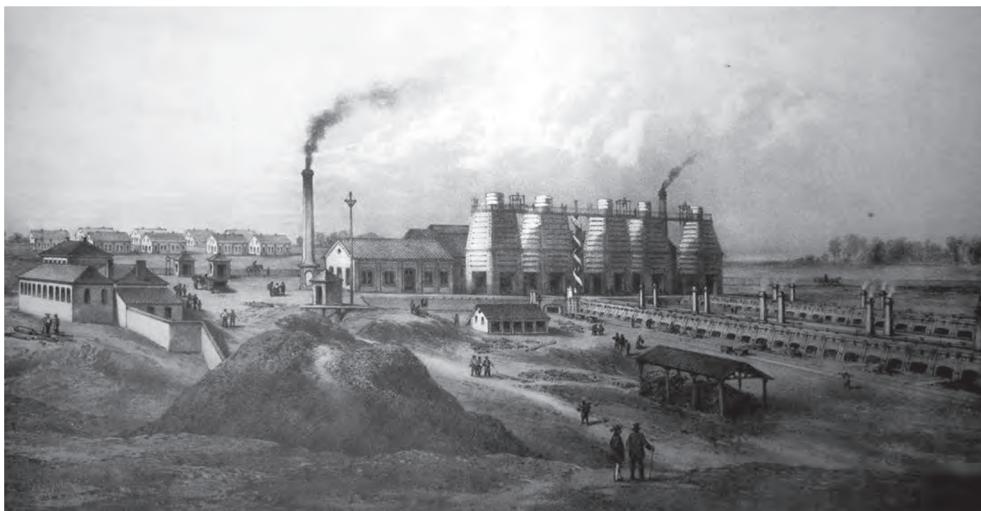
Hochofenanlage in Hörde 1860; Quelle: Phoenix Actien-Gesellschaft für Bergbau und Hüttenbetrieb 1852-1912, Denkschrift zum 60-jährigen Bestehen des Unternehmens
