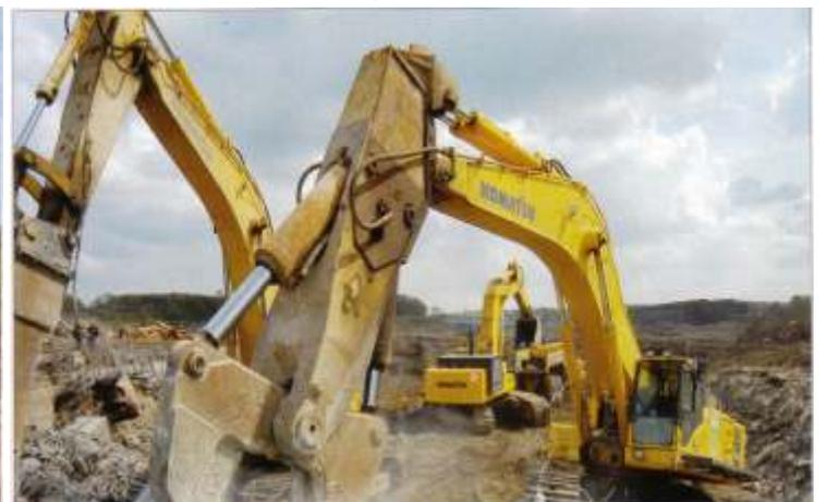
Mit schweren Geräten (Krupphammer) werden die Fundamente entfernt und teilweise für leichte Sprengungen vorbereitet. (linkes Bild)
