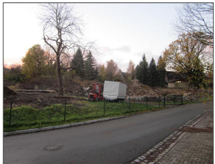
Nach Abriss freies Gelände
