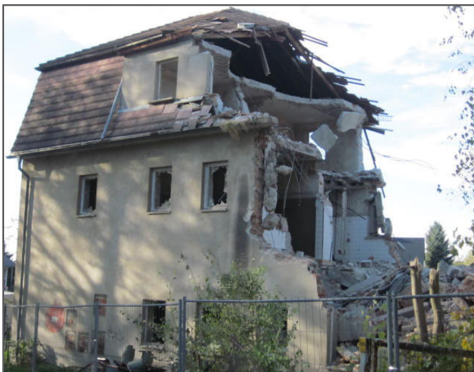
Abriss Neubau Fotos 4: Heinz Behrisch
