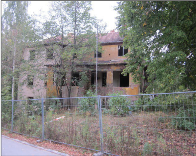
links – der nicht fertig gestellte Neubau rechts - der „Jäger“ während der Entkernung
