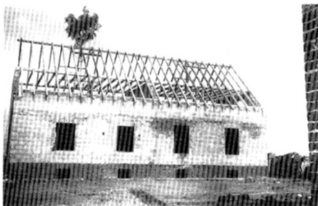
Der erste Rohbau
