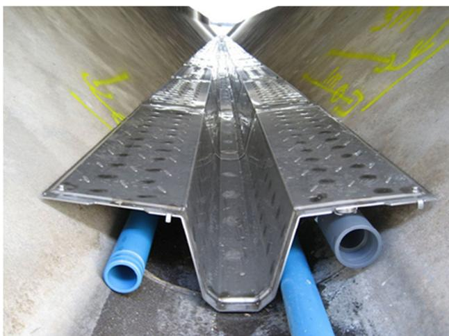
Foto 19: Wärmetauscher für Abwasserkanäle [Quelle: WeVo]<sup>19</sup>
